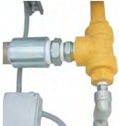
Рис. 22. Внешний вид резьбового соединения, слева направо: коллектор, рестриктор, переход, ниппель, тройник. Далее вверх: переход, трубопровод; вниз: переход, ниппель, отвод
