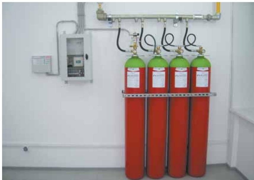
Рис. 25. Внешний вид смонтированной батареи модулей с инергеном
