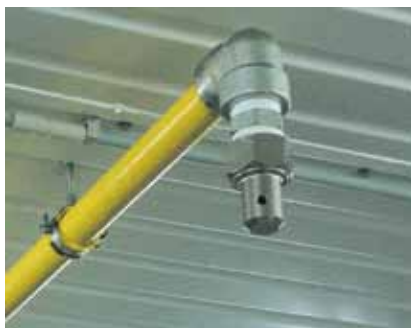
Рис. 20. Внешний вид насадка для инертных газов
